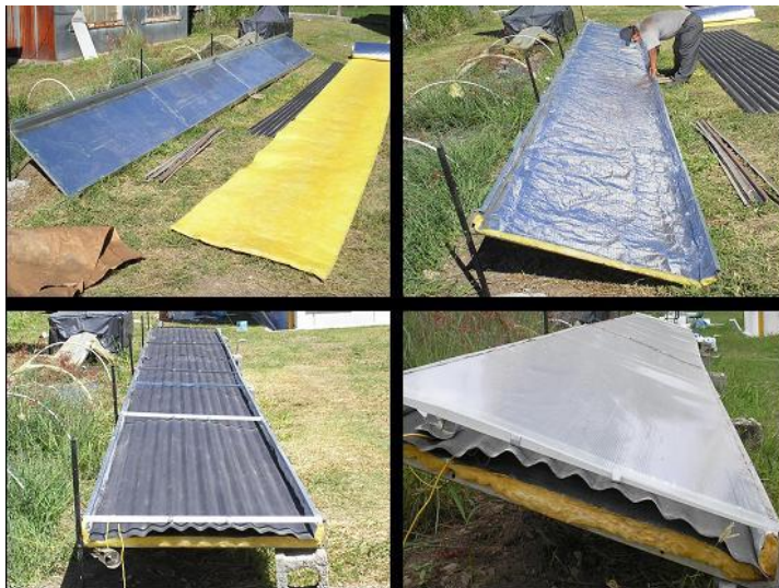
Figuras 2 a 5. Construcción del prototipo.
